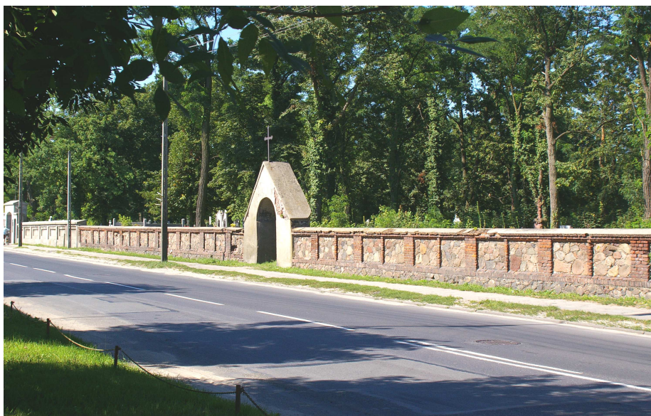
Zdj. Ogrodzenie cmentarza przy ul. Łaskiej.
