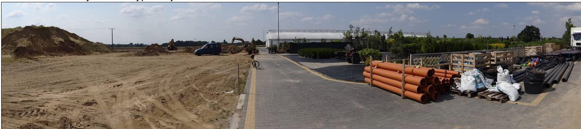
Fot. 2 Widok na analizowany teren od strony północnej.
