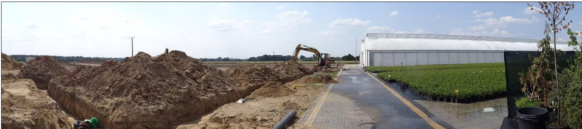
Fot. 1 Widok na analizowany teren od strony północnej.
